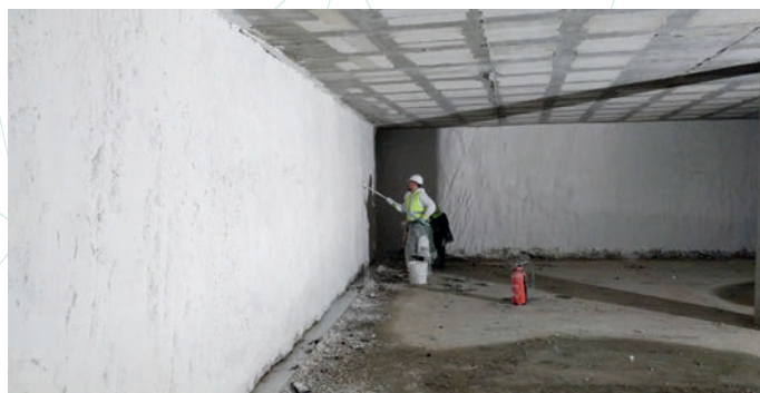
Impermeabilización pared parking
