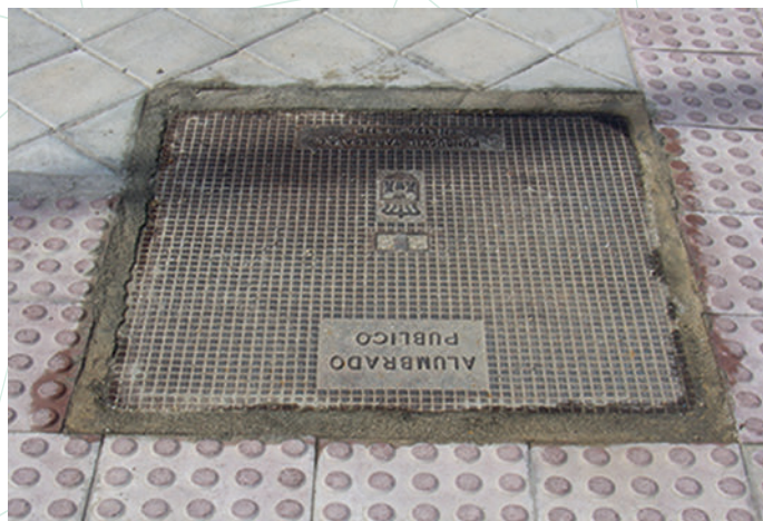
Anclaje de alcantarilla en vía pública
