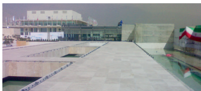
Impermeabilización de estanques Torre Borj e Milad (Teheran)
