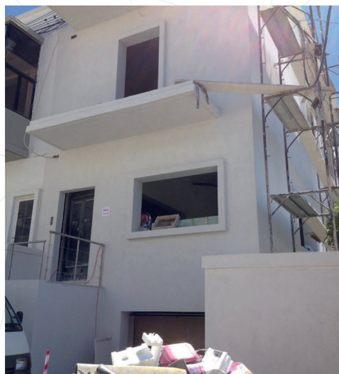
Protección de fachada con Tecmadry RPA (Malta)
