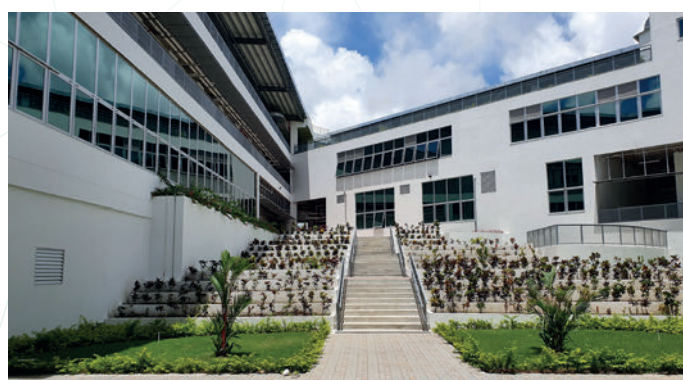
Impermeabilización de fuentes y jardineras en el ITSE (Panamá)
