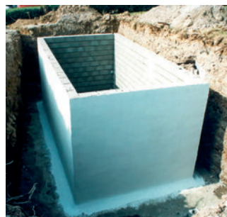
Impermeabilización de muros
