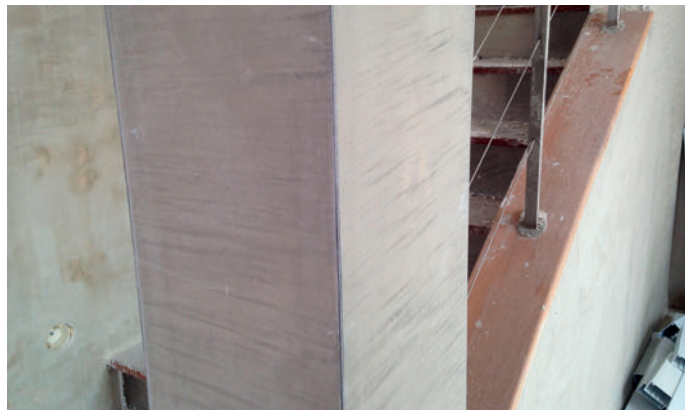
Reparación de hormigón
